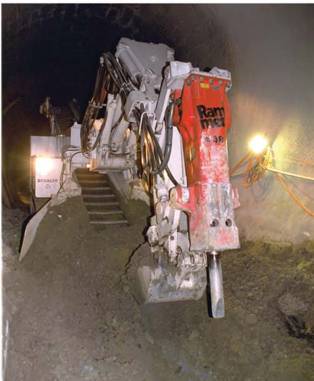
Die Tunnelvortriebsmaschine Schaeff Typ ITC 420 ...
