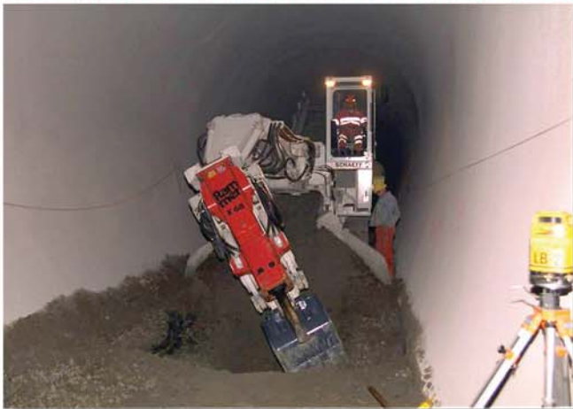
Präzises Arbeiten dank Kipp-Schwenkkonsole
