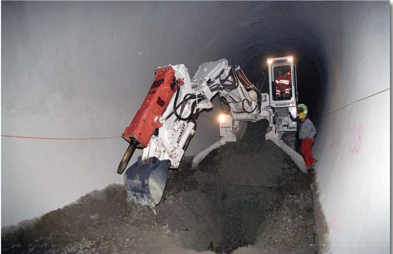
Die Tunnelvortriebs- und Lademaschine Schaeff Typ ITC 420 beim Sohlensauben mit dem Löffel
