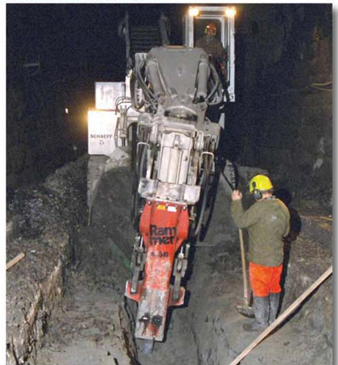
Die Tunnelvortriebs- und Lademaschine Schaeff Typ ITC 420 beim Sohlensauben mit dem Löffel
