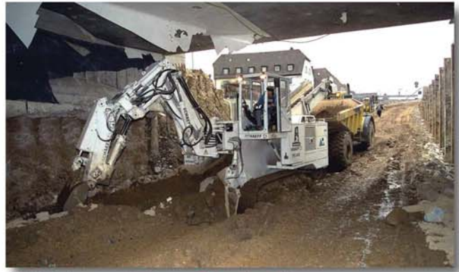
Sohlräumarbeiten am Tunnelportal
