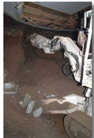
Hohe Abbauleistung unter der Decke
