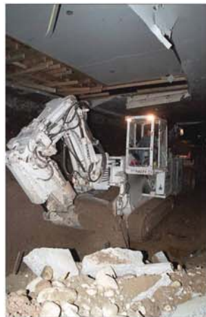
Laden von grösseren Betonblöcken
