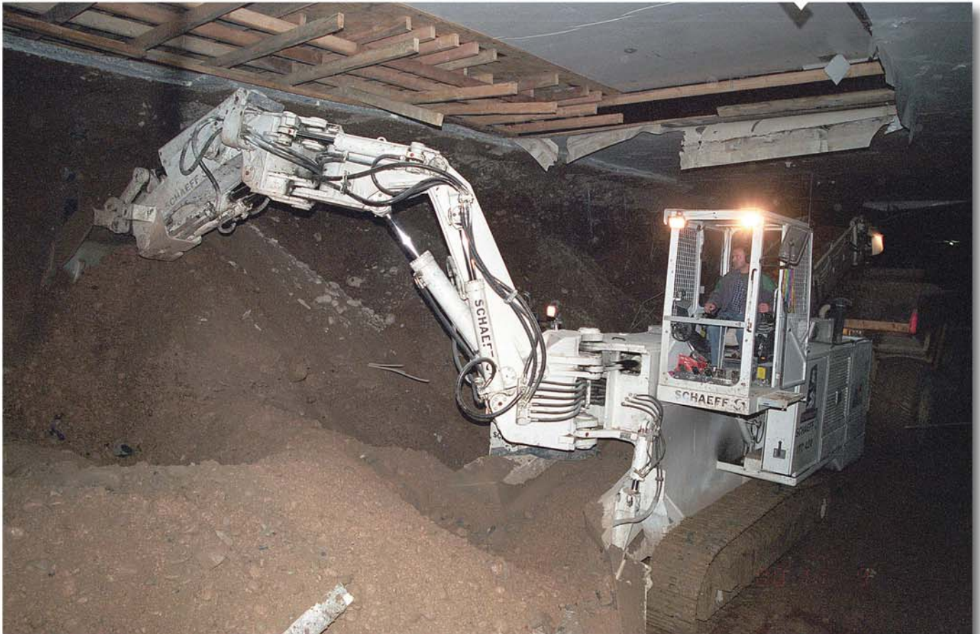
Die Tunnelvortriebs- und Lademaschine Schaeff Typ ITC 420 beim Leistungseinsatz in einem Tunnel mit Deckelbauweise
