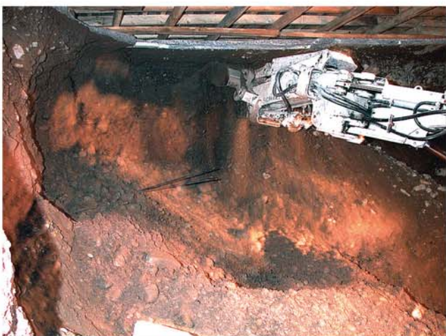
Präzises Ausbaggern, die Betondecke darf nicht beschädigt werden
