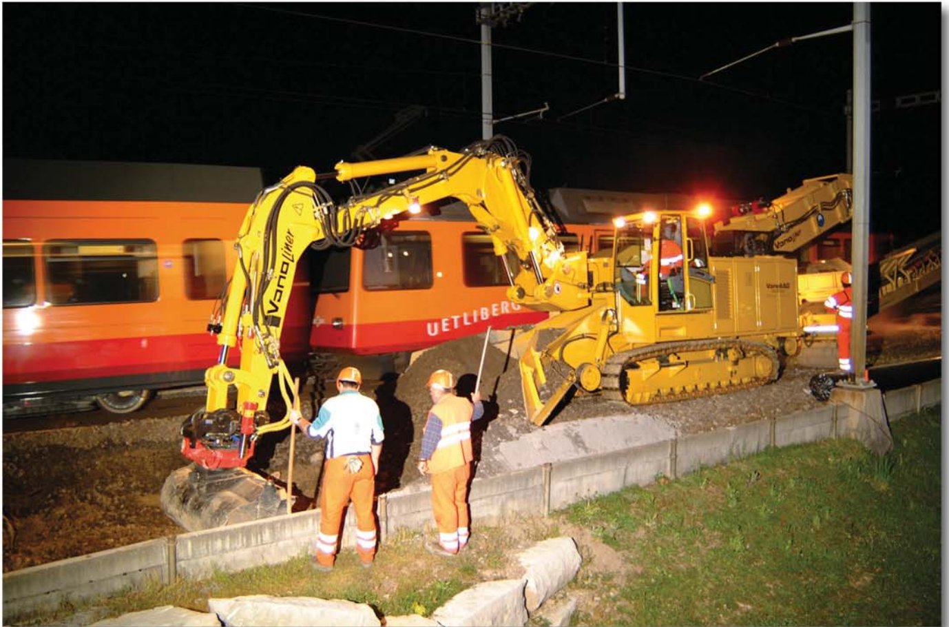
Die Ballast-Lademaschine Schaeff Typ ITC 312 VL2 mit dreiteiliger Arbeitseinrichtung in Ladeposition
