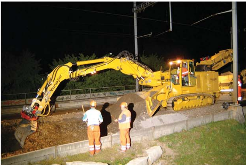
Geringer Platzbedarf dank integriertem Förderband
