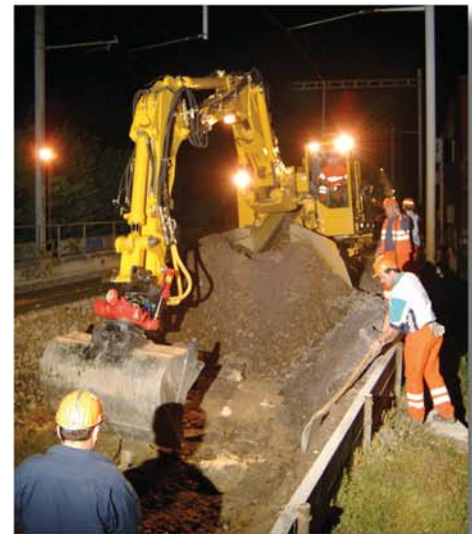
Genaueres Arbeiten dank Roto-Tilt Einrichtung
