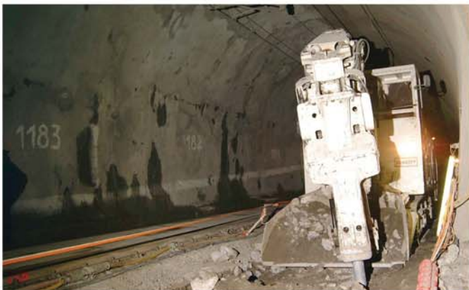
Die Tunnelvortriebsmaschine Typ ITC 320 in Arbeitsposition mit Hammer V45
