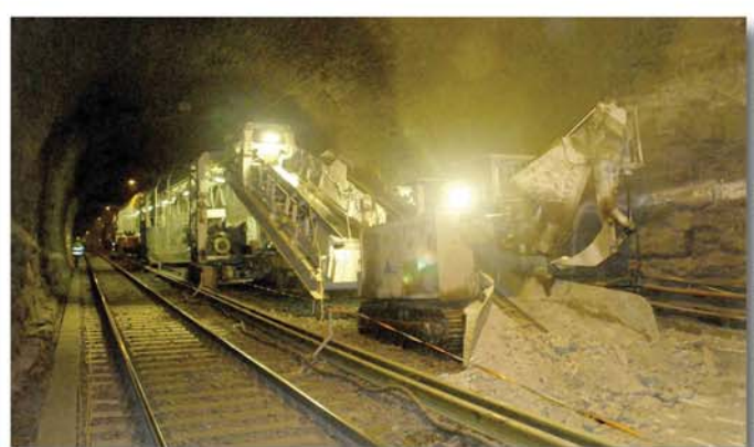
Die Tunnellademaschine ITC 112 in Ladeposition auf Bandanlage
