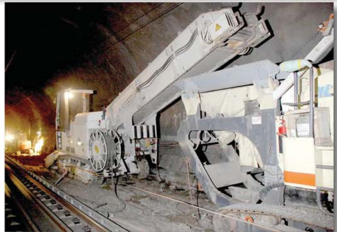
Die Tunnelvortriebsmaschine ITC 320 auf Brechanlage
