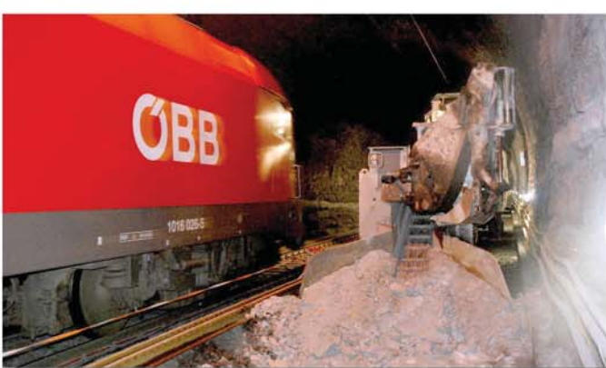
Die Tunnellademaschine ITC 112 vorbeifahren vom Zug
