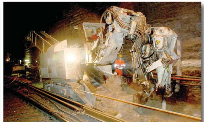
Die Tunnelvortriebsmaschine Typ ITC 320 in Ladeposition mit Löffel
