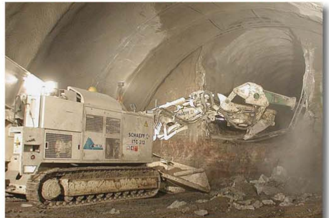
Abb.13: Ausweitung des Pilotstollens im Westen
