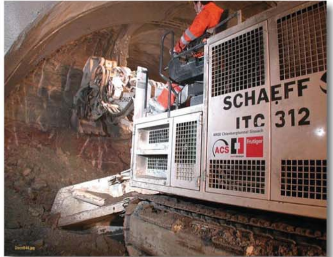
Abb. 12: Bei der Kalottenausweitung im Westen
