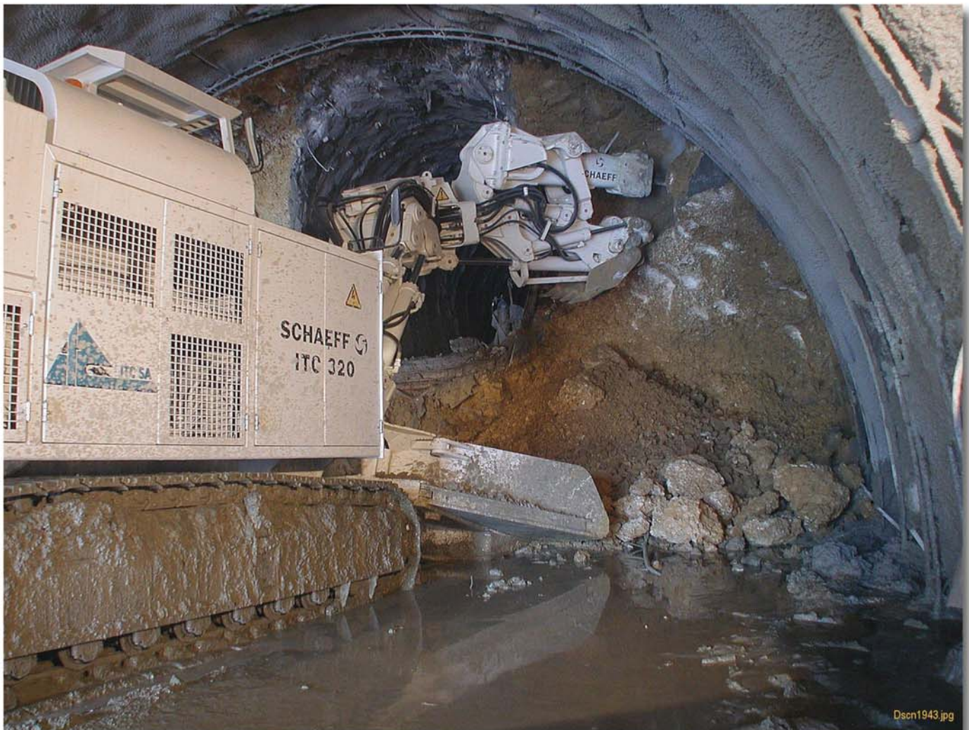
Abb. 1: Schlagendes Lösen beim Ostportal. Tunnelvortriebs- und Lademaschine Schaeff Typ ITC 320
