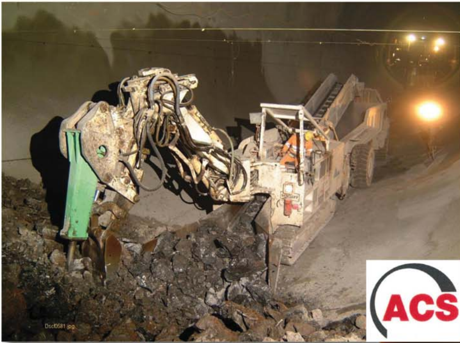
Abb. 7 Beim Strossenaushub im Westen
