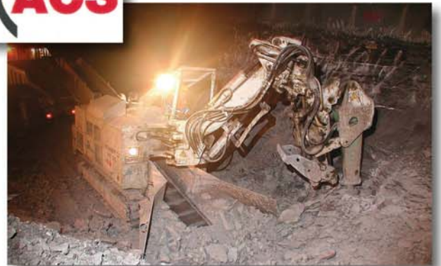
Abb. 10: Beim Strossenaushub im Westen
