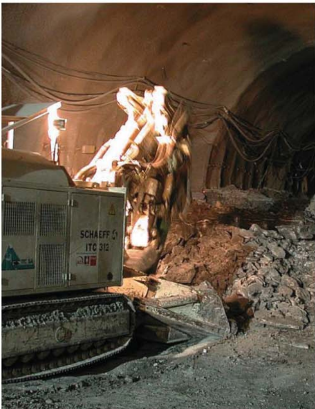
Abb. 11: Beim Kalottenausweitung im Westen
