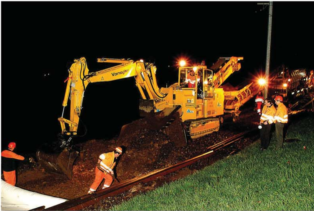
Bild 7: Laden zwischen Hang und Strasse in 50 ‰ Gefälle.
