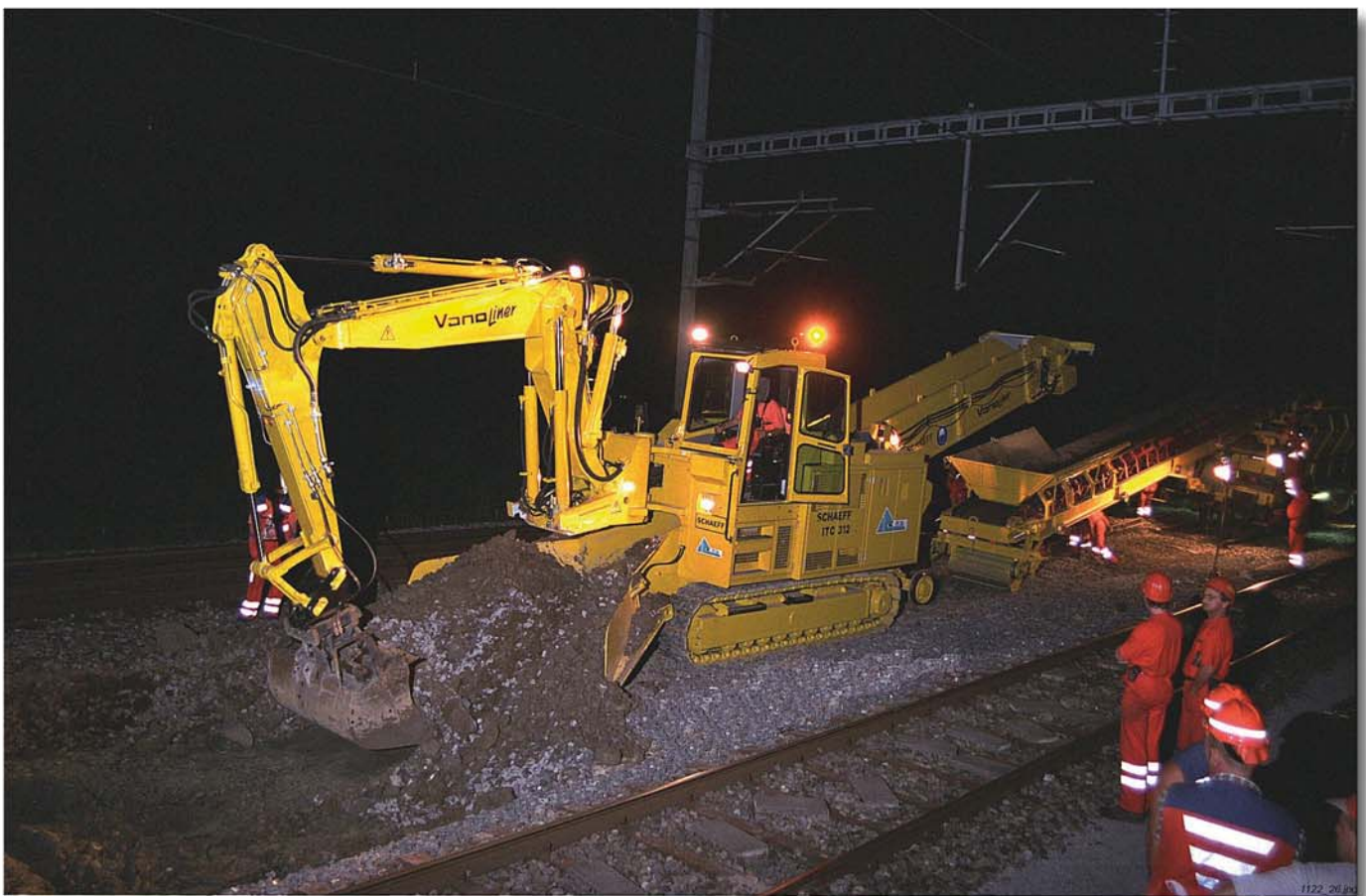
Bild 1: Lademaschine Schaeff Typ ITC 312 beim Aushub im Bahnhofbereich AU (ZH)
