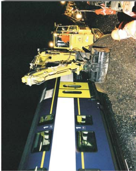
Bild 2: Dreiteilige Arbeitseinrichtung mit Schwenköffel
