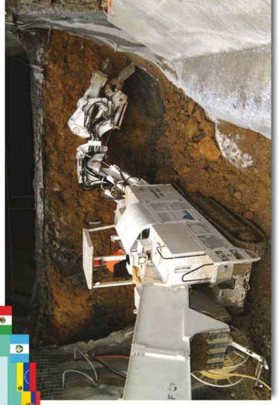
Bild unten: Genaueres Profilieren der Strosse mit Ladelöffel
