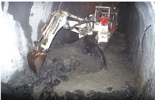
Die Schuttermaschine Schaeff Typ ITC 312 H3 beim Sohlenreinigen
