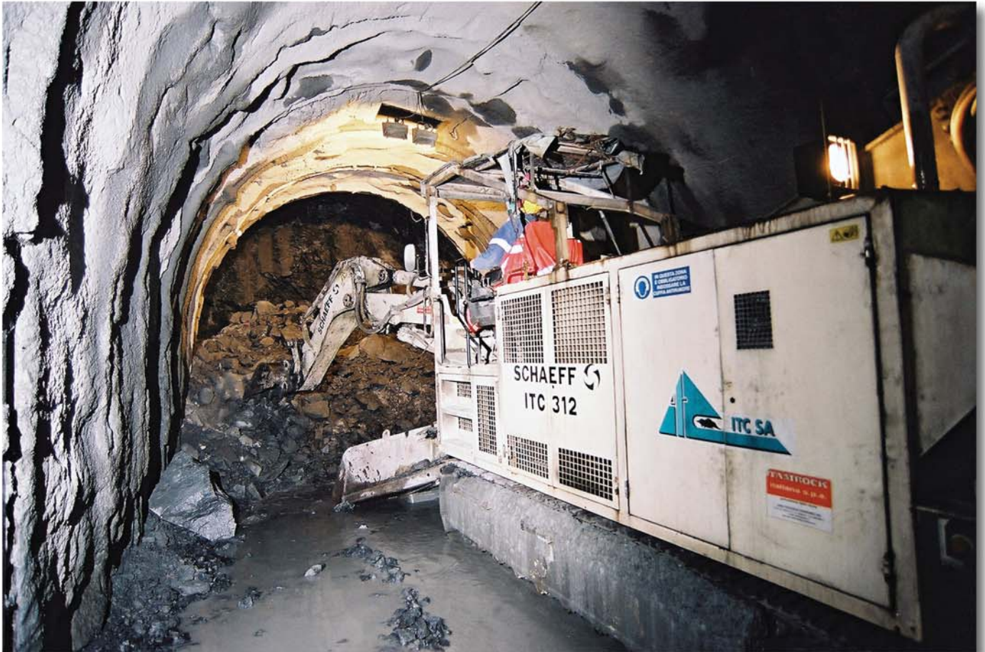
Die Schuttermaschine Schaeff Typ ITC 312 H3 in Ladeposition
