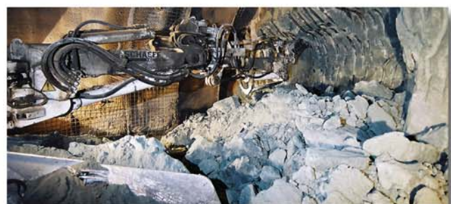
Profilgenauer Ausbruch dank Kipp-Schwenkkonsole
