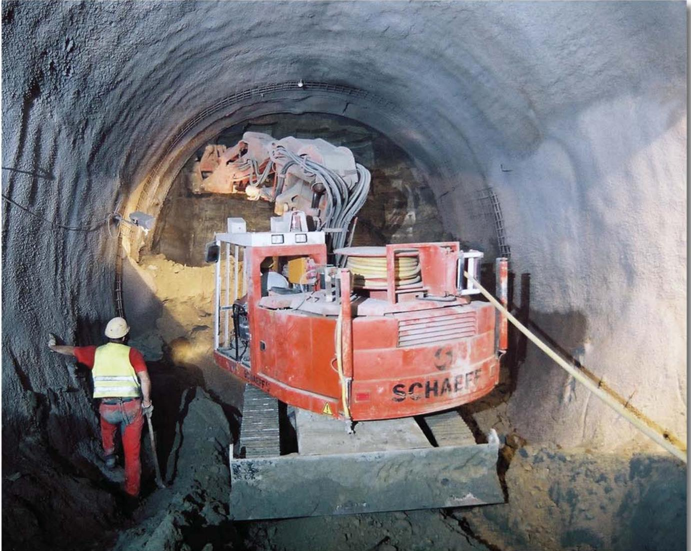
Vortrieb im typischen Ubahnquerschnitt in München
