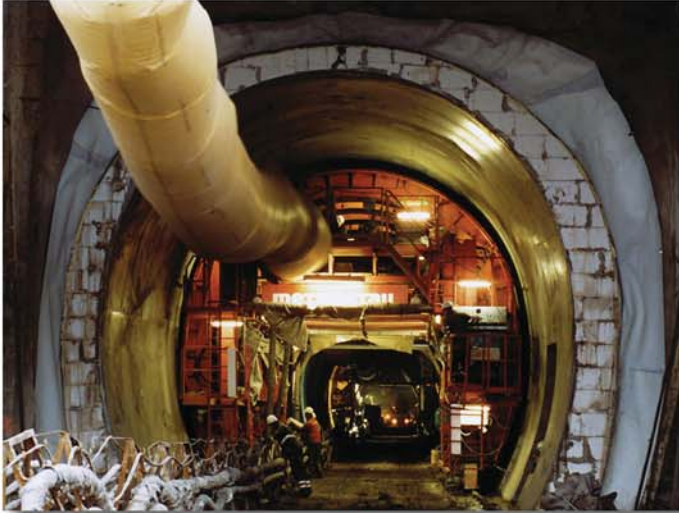
Schalung für die Tunnelinnenschale
