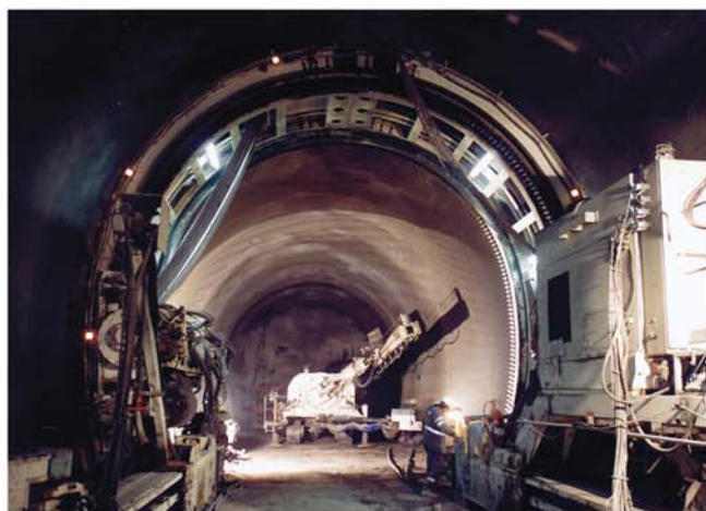
Die Perforex-Sägemaschine und mittig die Rohrschirmbohrmaschine
