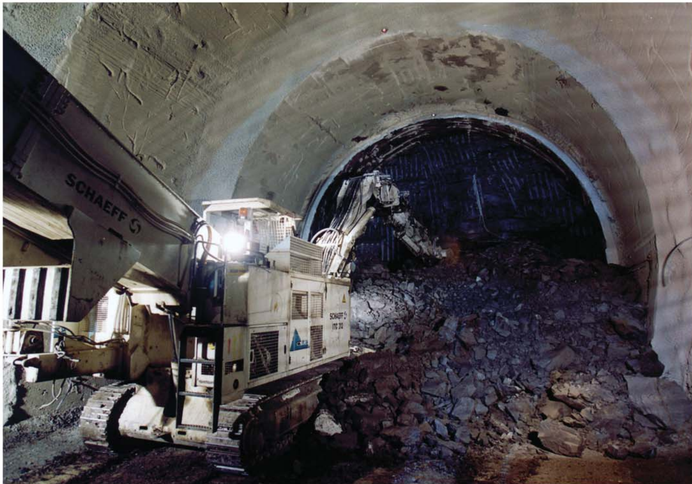
Die Tunnelvortriebsmaschine Schaeff Typ ITC 312 N1 in Aushubposition unter der vorbetonierten Kalotte
