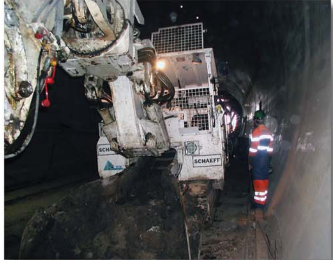
Die kompakte Tunnelvortriebsmaschine Schaeff Typ ITC 112 M4 eingesetzt beim Ulmenstollenvortrieb
