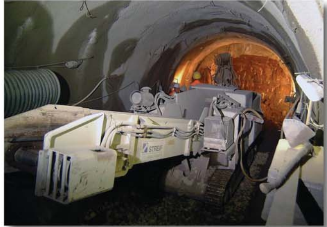
Kompakte Vortriebsmaschine im engen Querschnitt
