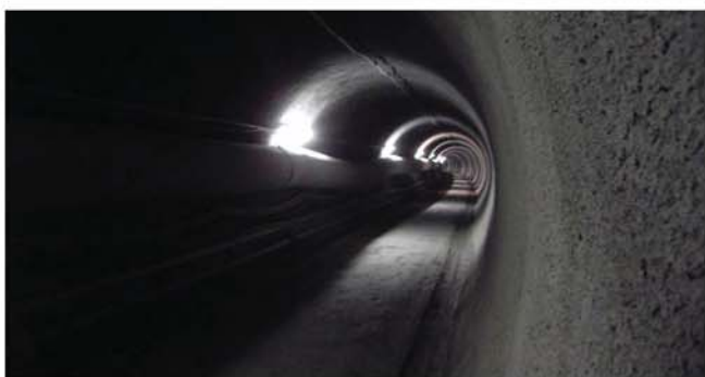
Blick in existierenden Zugangsstollen
