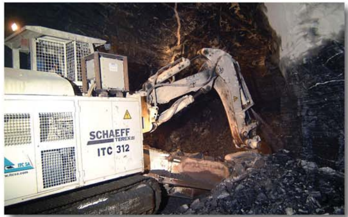
Die Lademaschine beim Räumen von der Ausweichnische.
