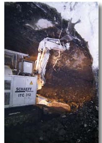
Bereissen der gelösten Blöcke in der Firse
