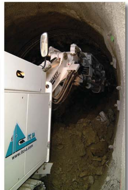
Die ITC 120 beim Lösen des weichen Material
