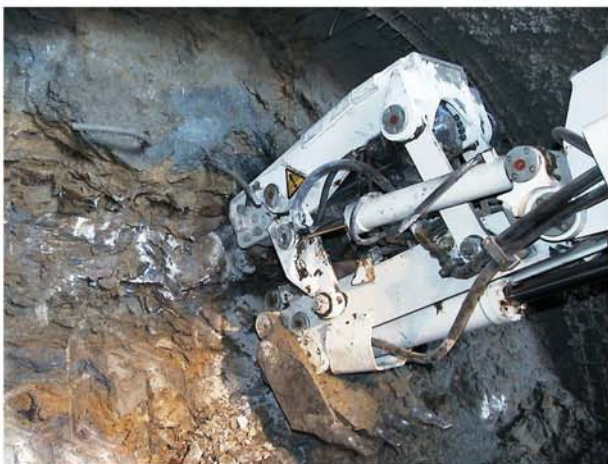
Patentierte Werkzeugträgerereinheit mit Hammer und Löffel beim Hammervortrieb
