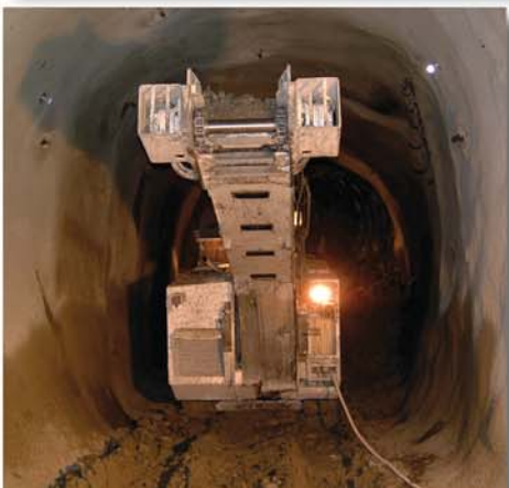
Enge Platzverhältnisse im Tunnelquerschnitt
