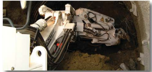
Profilgenauer Ausbruch dank Kipp- Schwenkkonsole
