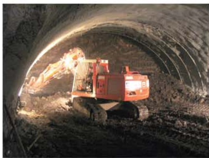
Der Tunnelbagger Typ TE 210 im Tunnelquerschnitt 52 m 2 , Firsthöhe 5.4 m, Sohlenbreite 12 m.
