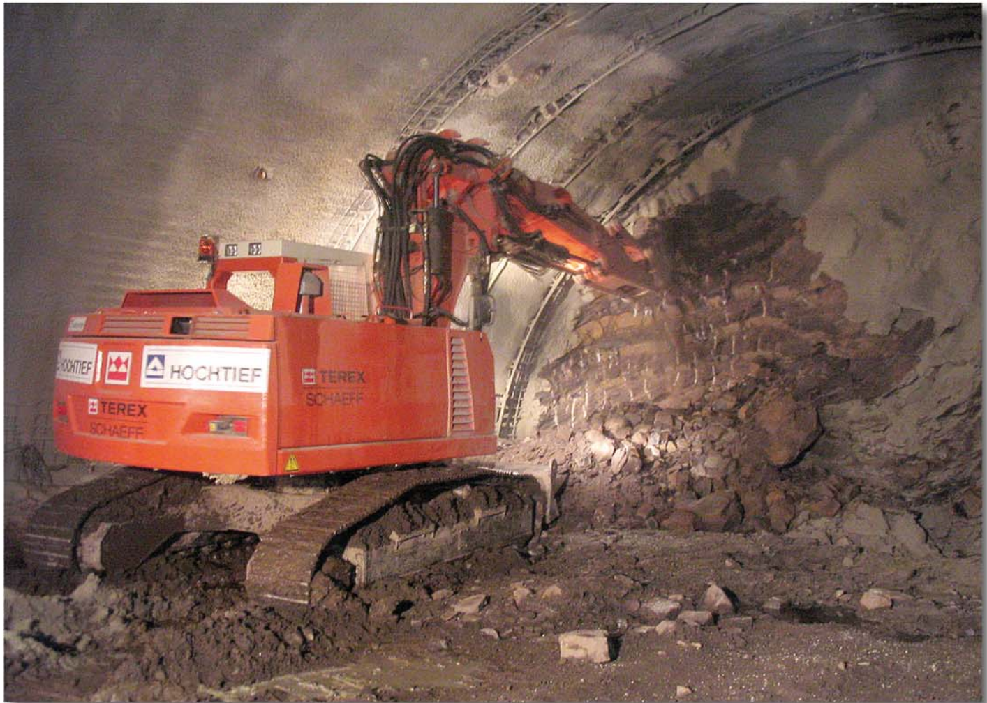
Der Tunnelbagger Typ TE 210 im Tunnelquerschnitt 52 m 2 , Firsthöhe 5.4 m, Sohlenbreite 12 m.
