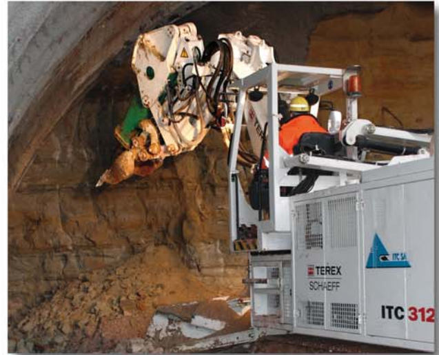
Lösen mit dem Löffel in den weichen Formationen
