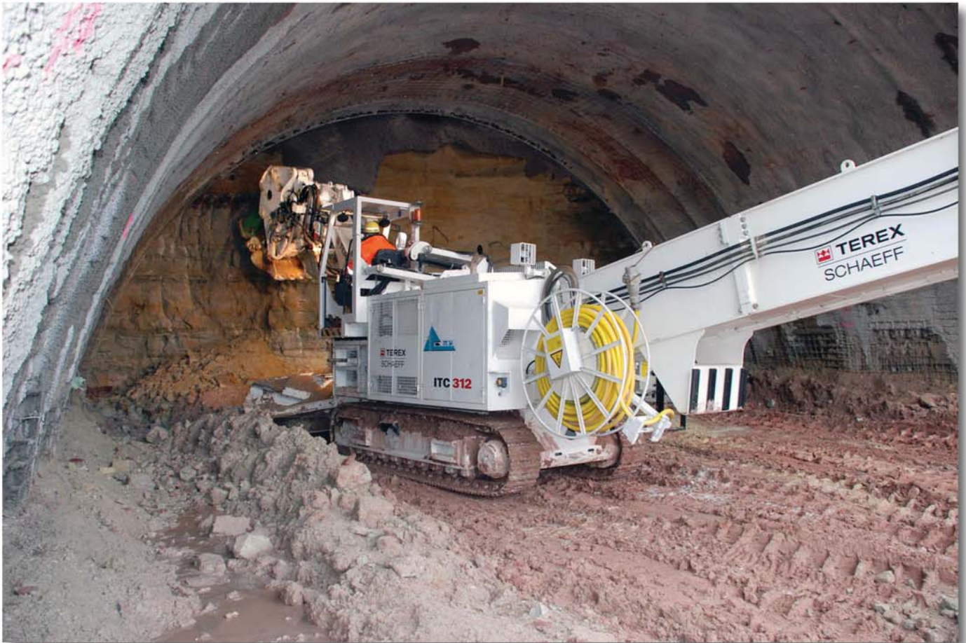
Die Tunnelvortriebsmaschine Typ ITC 312 H6 in Hammerposition in der Kalotte. Sonderausrüstung: Schwenkkabine
