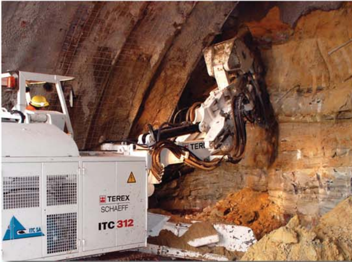
Lösen mit dem Hammer in harten Formationen
