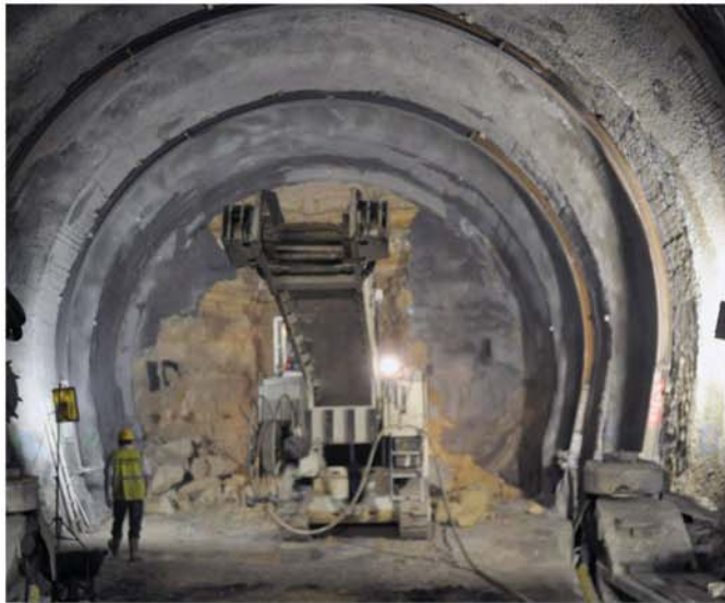
Abb. 13: Vortrieb im Tunnel
