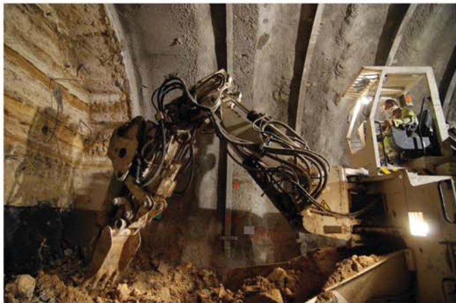
Abb. 7: ITC 312 mit Schwenkkabine
