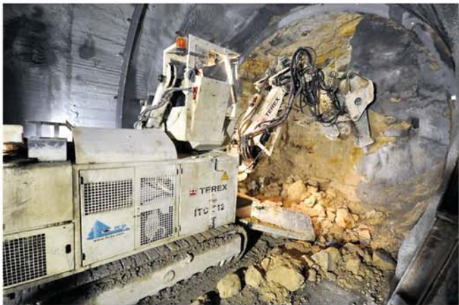
Abb. 6: Hämmern des harten festgelagerten Mergels
