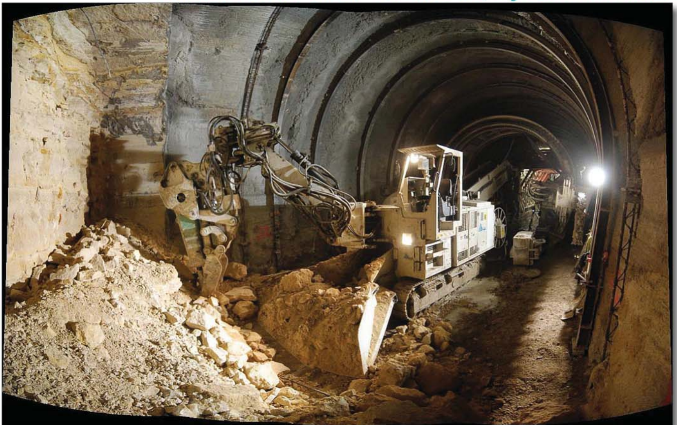
Abb. 1: ITC 312H6 im Mergel und Schotter von Paris
