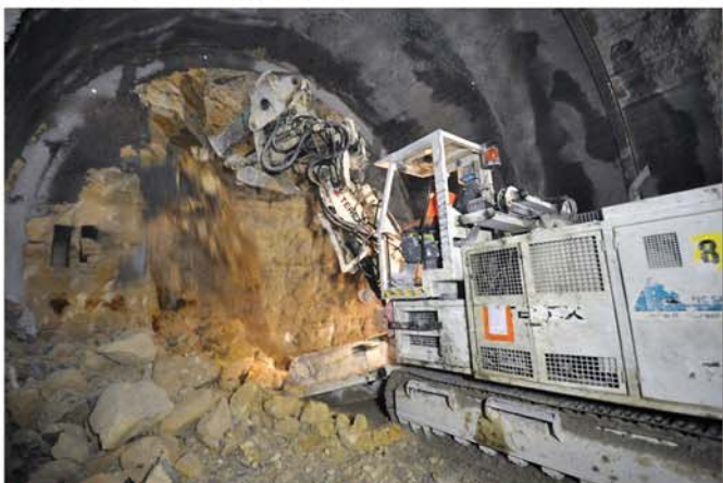
Abb. 10: ITC 312 Lösen mit Hammer
