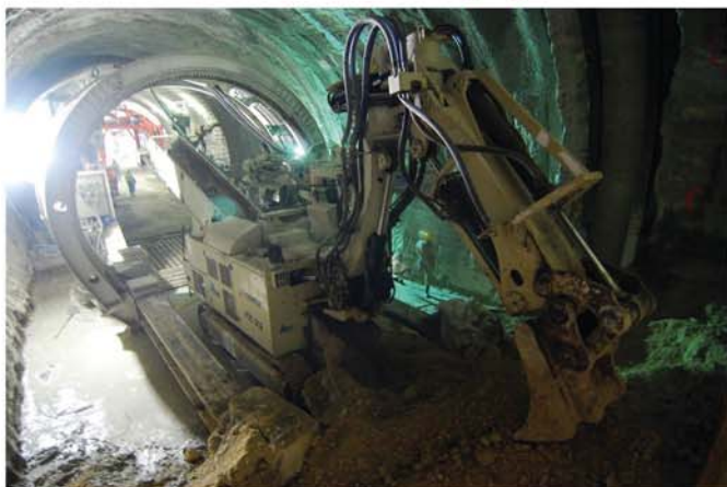
Abb. 11: ITC 312 mit AE H1, arbeiten mit Löffel
