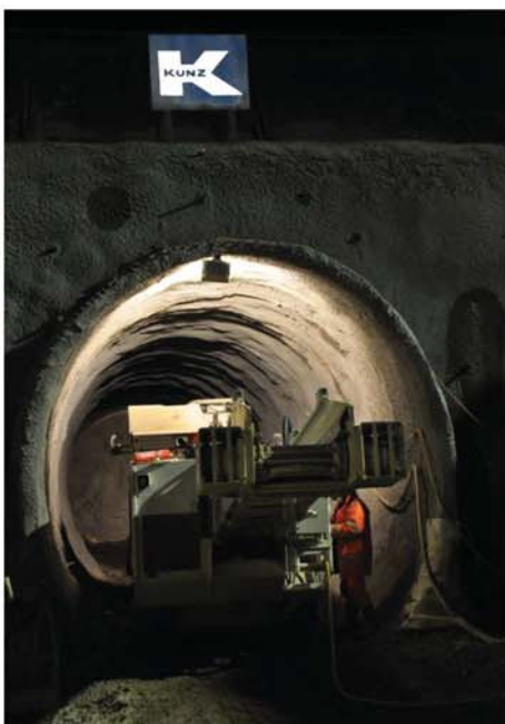
Abb. 8: ITC 120 beim Tunnelportal
