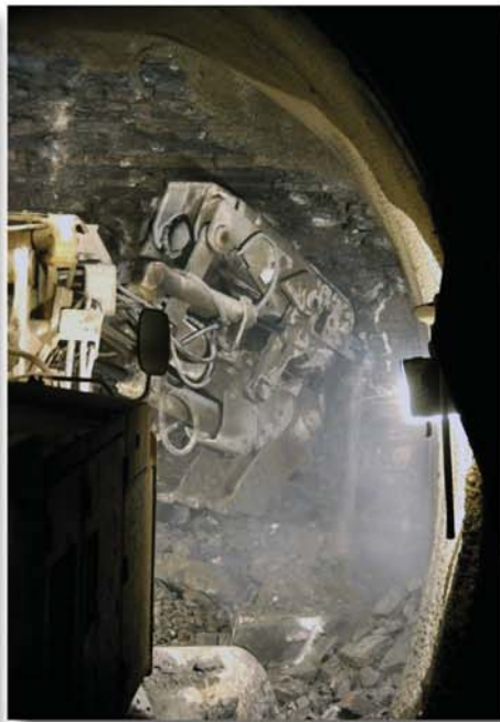
Abb. 5: Lösen mit dem Hammer
