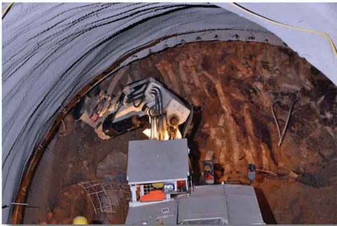
Abb. 6: Vortrieb der voreilenden Kalotte
