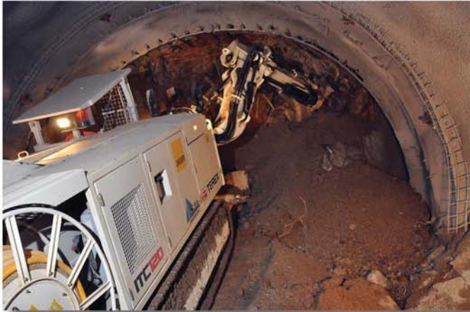
Abb. 8: Vortrieb in der Aufweitung
