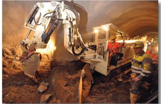
Abb. 9: ITC 120 bei der Sohlenreinigung
