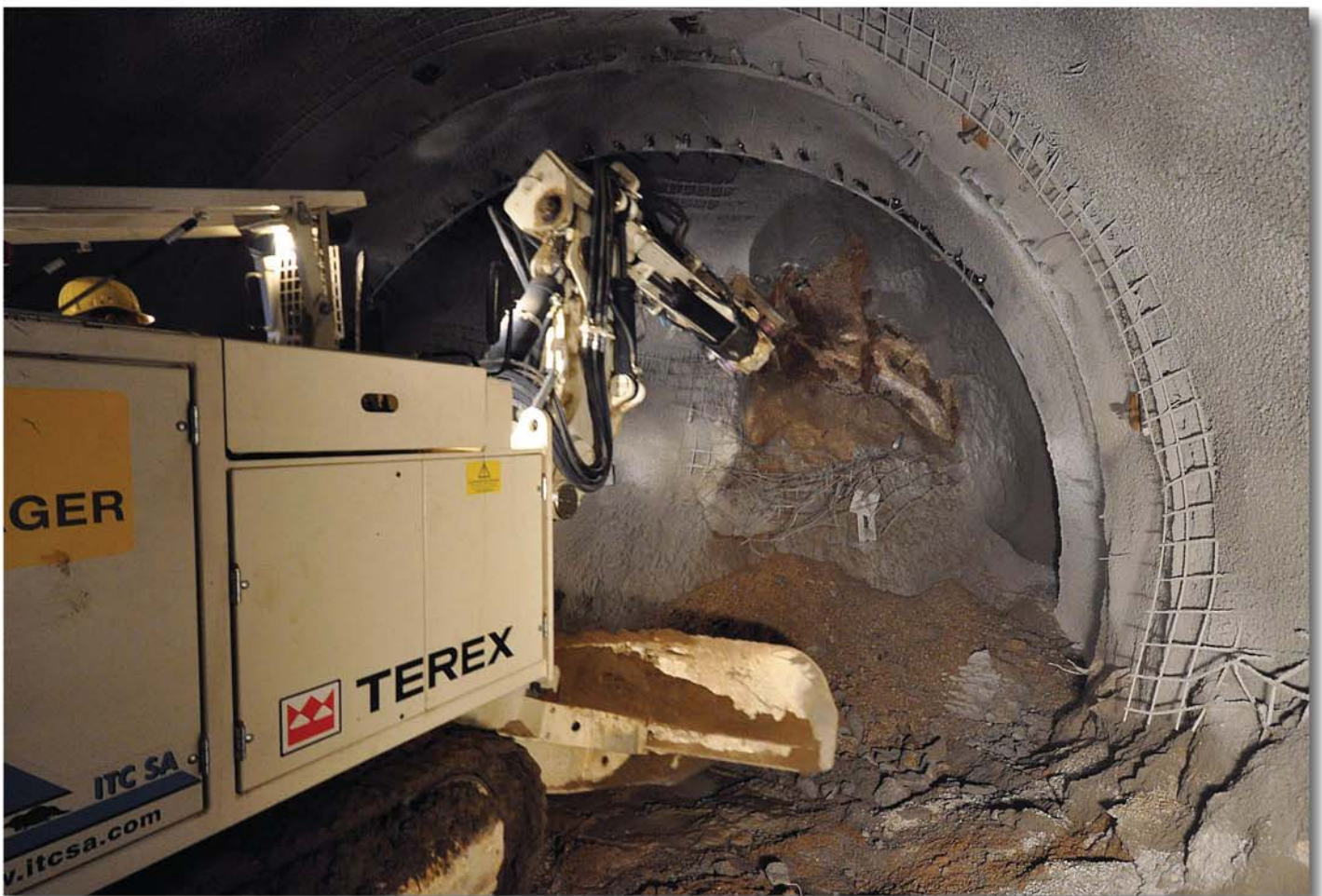
Abb. 1: ITC 120 F3 im Kalottenvortrieb bei der Ausweitung
