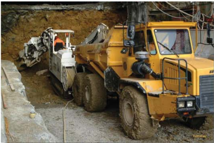
Fig. 9 : Chargement sur des tombereaux de 25t.
