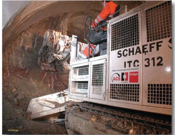
Fig. 12 : Lors du terrassement du stross à l'Ouest
