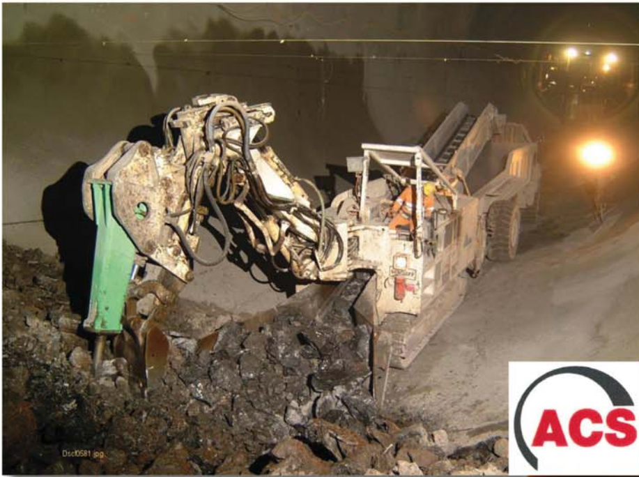
Fig. 7 : Lors du terrassement du stross à l'Ouest
