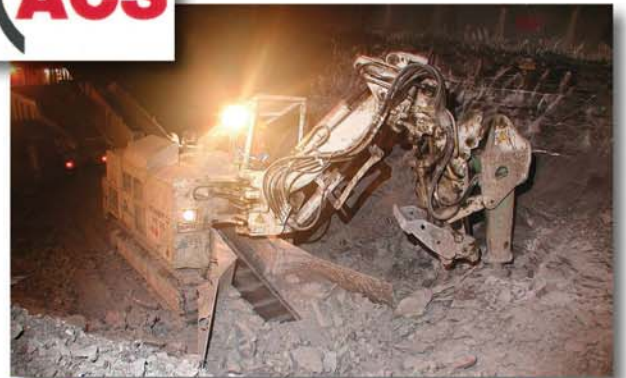
Fig. 10 : Lors du terrassement du stross à l'Ouest
