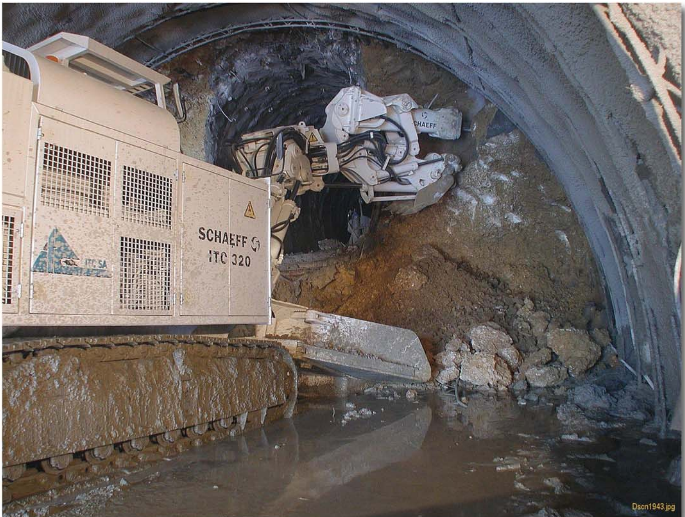
Fig. 1 : Abattage au brise roche au portail Est. Machine d'avancement et de chargement de tunnels Schaeff modèle ITC 320
