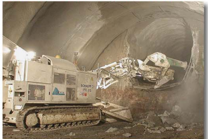
Fig. 13 : Elargissement de la galerie pilote à l'Ouest
