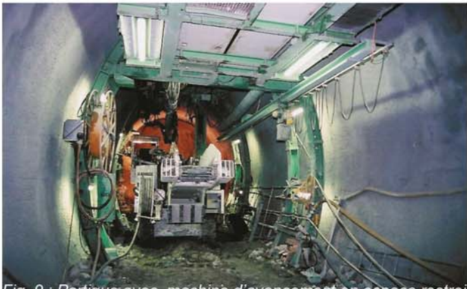
Fig. 9 : Portique avec machine d'avancement en espace restreint
