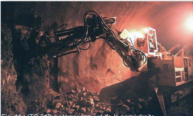
Fig. 11 : ITC 312 au terrassement de la paroi droite
