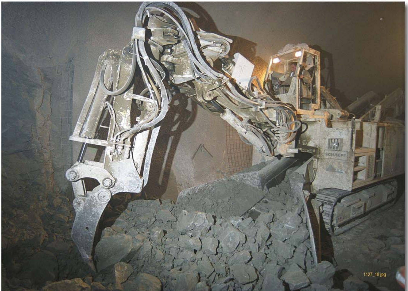
Fig. 1 : Machine d'avancement et de chargement Schaeff de type ITC 312H1 au forage minier dans le deuxième tube.
