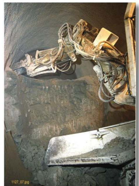
Fig. 18 : Travaux de précision
