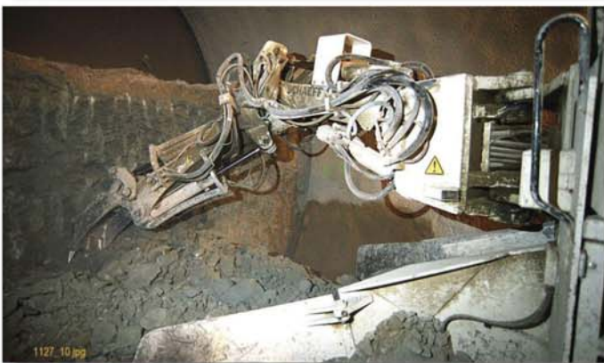
Fig. 12 : ITC 312 au terrassement de la marnes dure
