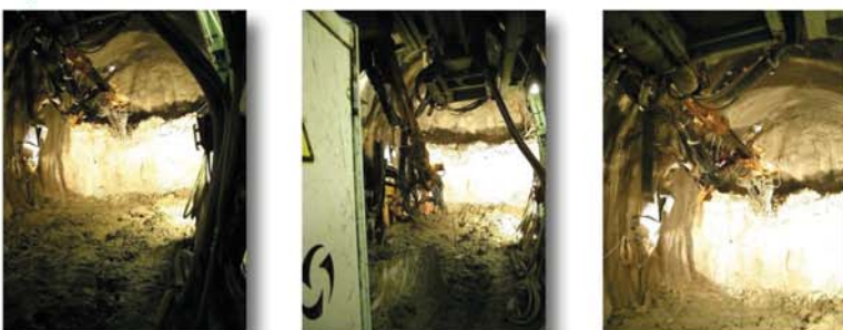
Fig. 13 à 15 : Foreuse sur le portique de forage GTA
