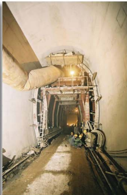
Fig. 12 : Coffrage du tunnel principal
