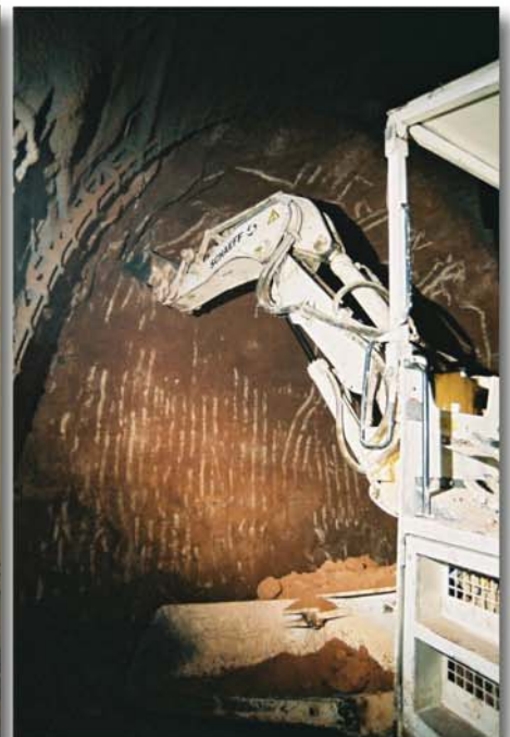
Fig. 13: Terrassment dans des zones tendres du tunnel principal
