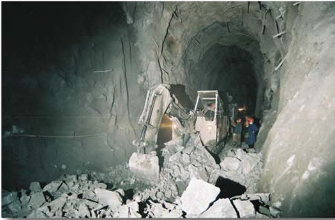
Fig. 7 : Marinage dans le tunnel principal
