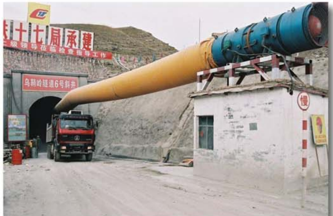
Fig. 10 : Portail d'entrée de la galerie d'accès
