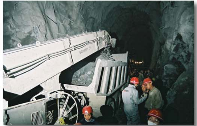
Fig. 8 : Chargement sur les camions-bennes Isuzu de 20 t
