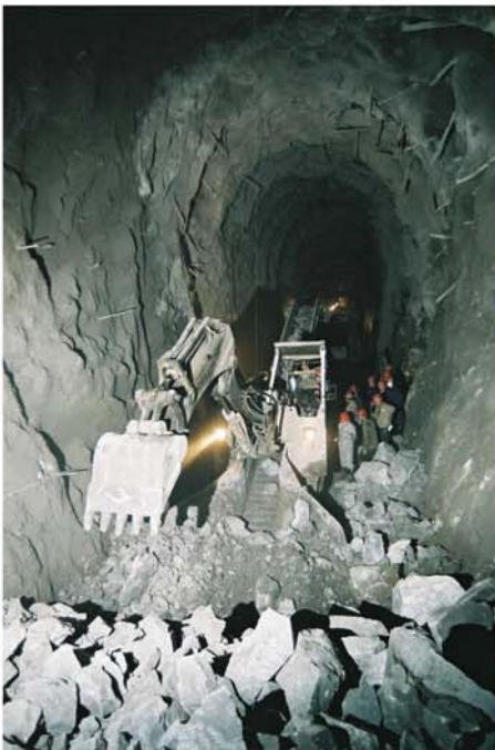
Fig. 11 : Marinage dans le tunnel principal
