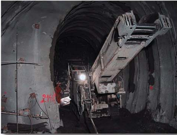
Fig. 6 : ITC 312 à l'avancement nord, à l'arrachement
