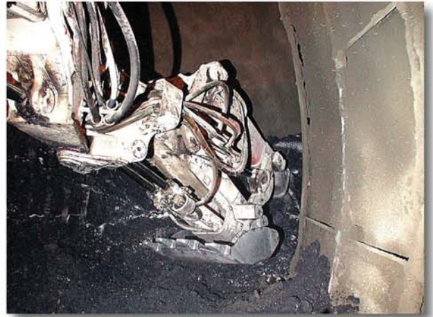
Fig. 7 : ITC 420 à l'avancement sud, à la taille
