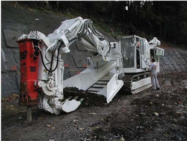
Fig. 10 : ITC 420 à l'avancement sud
