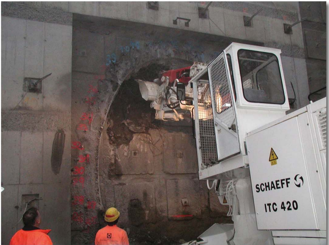
Fig. 1 : Machine d'avancement et de chargement de tunnel Schaeff de type ITC 420 pour l'avancement mécanique au sud
