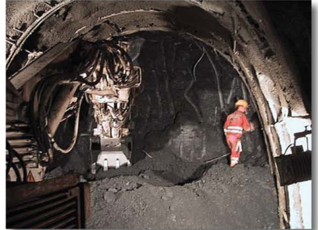
9 : ITC 420 à l'avancement sud, au chargement
