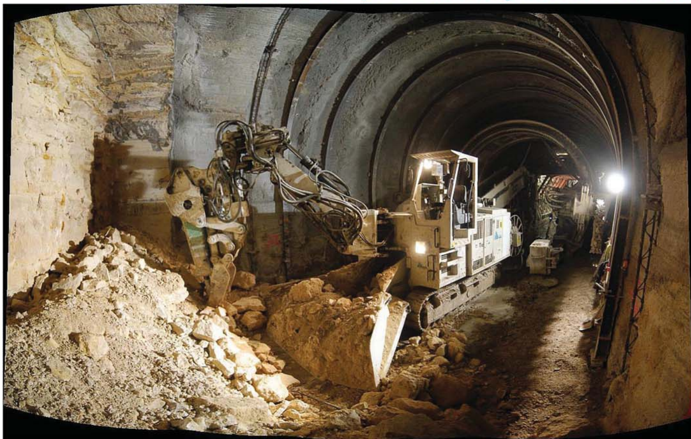
Fig. 1: ITC 312 H6 dans les marnes et caillasses parisiennes
