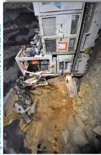
Fig 3: Machine de terrassement ITC 312 H6 au front
