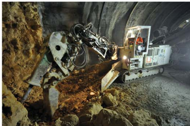
Fig. 9: ITC 312 au nettoyage du radier
