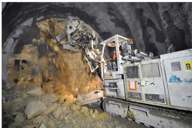
Fig. 10: ITC 312 Excavation au brise roche
