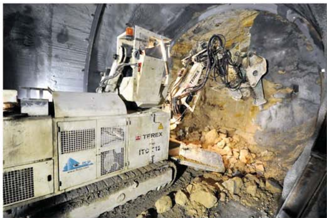
Fig. 6 Terrassement des pieds de cintre
