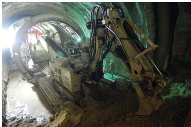
Fig. 11: ITC 312 avec le bras H1, terrassement au godet
