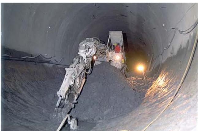
Sohlen- Absenken bzw. Reinigen
