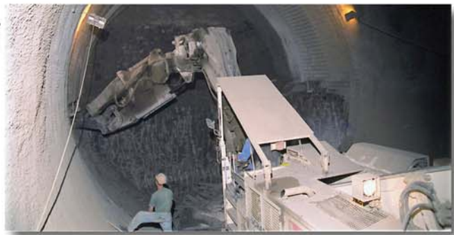
Präziser Ausbruch dank Kipp- Schwenkconsole
