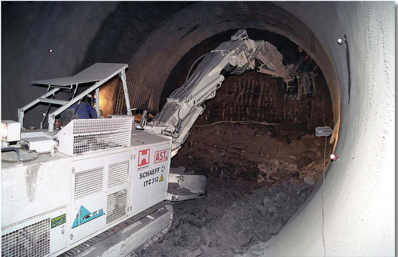
Die Tunnelvortriebs- und Lademaschine Schaeff Typ ITC 312 N1s beim Vollaussbruch im kreisrunden Querschnitt, Ø 8.6 m
