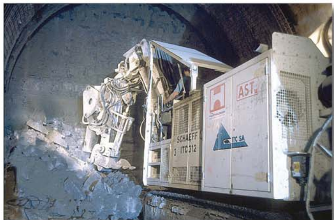
Hammereinsatz bei harten Kalksteinbänken
