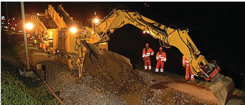
Genaueres Arbeiten dank Roto-Tilt Einrichtung
