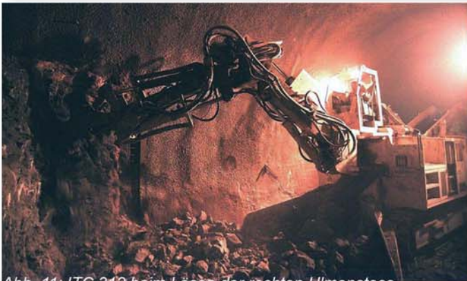
Abb. 11: ITC 312 beim Lösen der rechten Ulmenstoss
