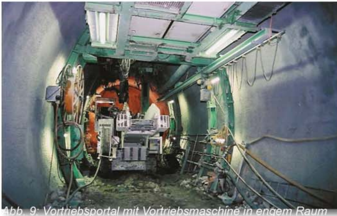
Abb. 9: Vortriebsportal mit Vortriebsmaschine in engem Raum
