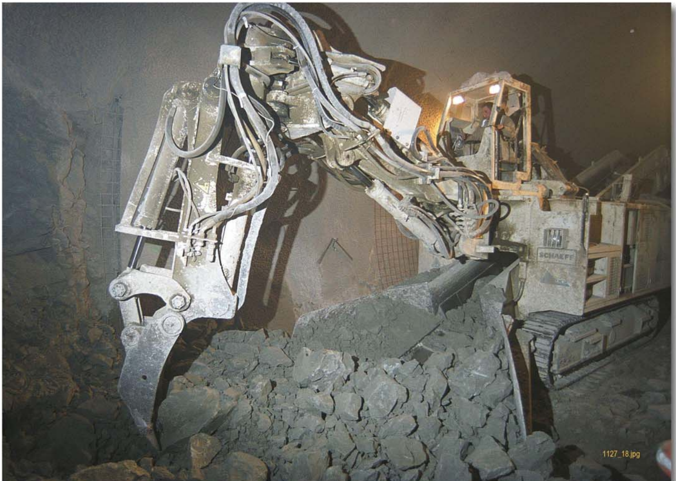
Abb. 1: Tunnelvortriebs- und Lademaschine Schaeff Typ ITC 312H1 beim bergmännischen Vortrieb in der zweiten Röhre.
