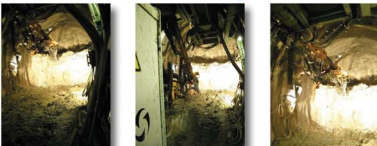
Abb. 13-15: Bohranlage auf dem GTA-Tunnelvortriebsportal
