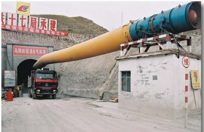
Abbildung 10: Portal des Zugangsstollens
