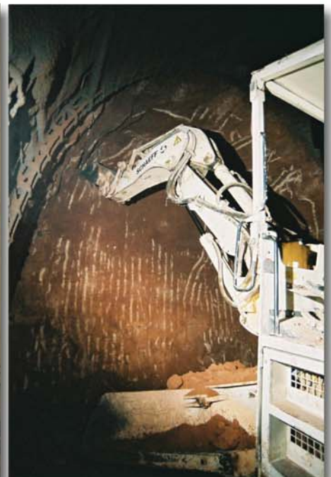
Abbildung 13: Zugangstunnel in weichem Gestein
