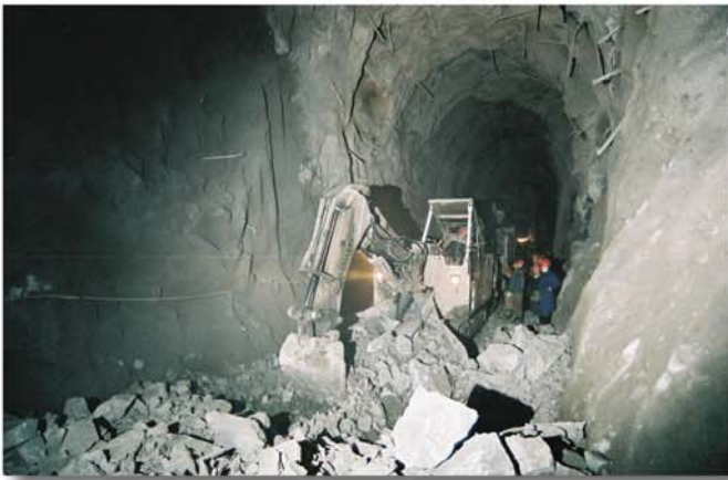
Abbildung 7: Schüttern im Haupttunnel
