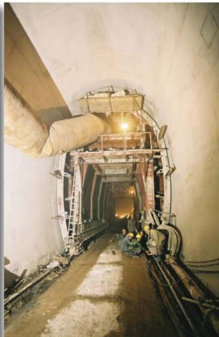
Abbildung 12: Schalung im Haupttunnel
