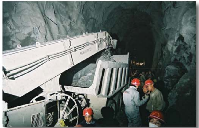
Abbildung 8: Beladen der 20t-Dumper von Isuzu
