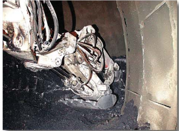
Abb. 7: ITC 420 im Südvortrieb beim Lösen
