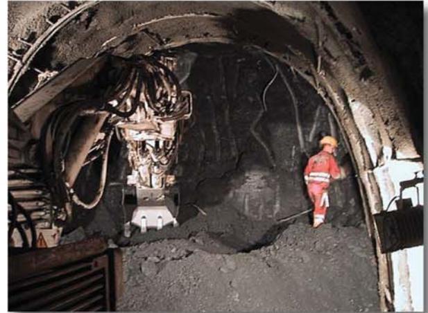
Abb. 9: ITC 420 im Südvortrieb beim Laden
