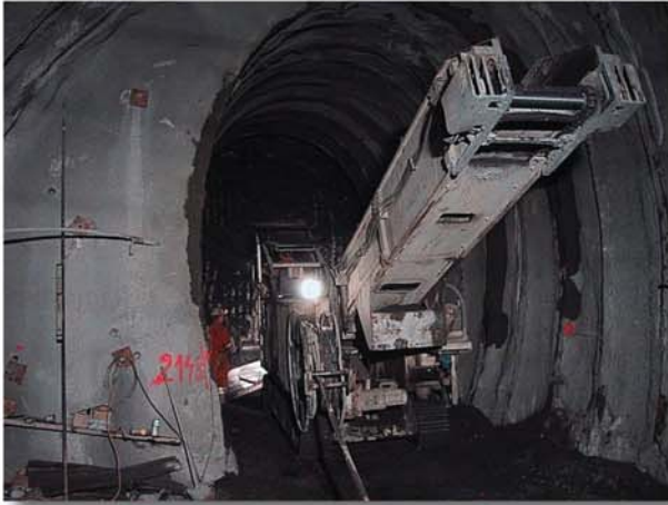
Abb. 6: ITC 312 im Nordvortrieb, beim Reissen
