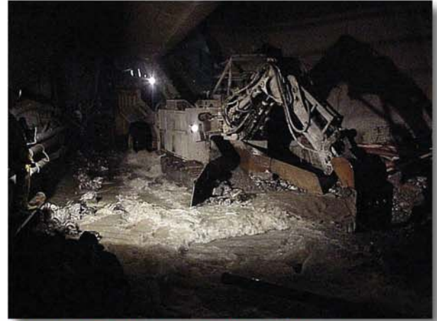
Abb. 11: ITC 312 im Nordvortrieb, im Wasser
