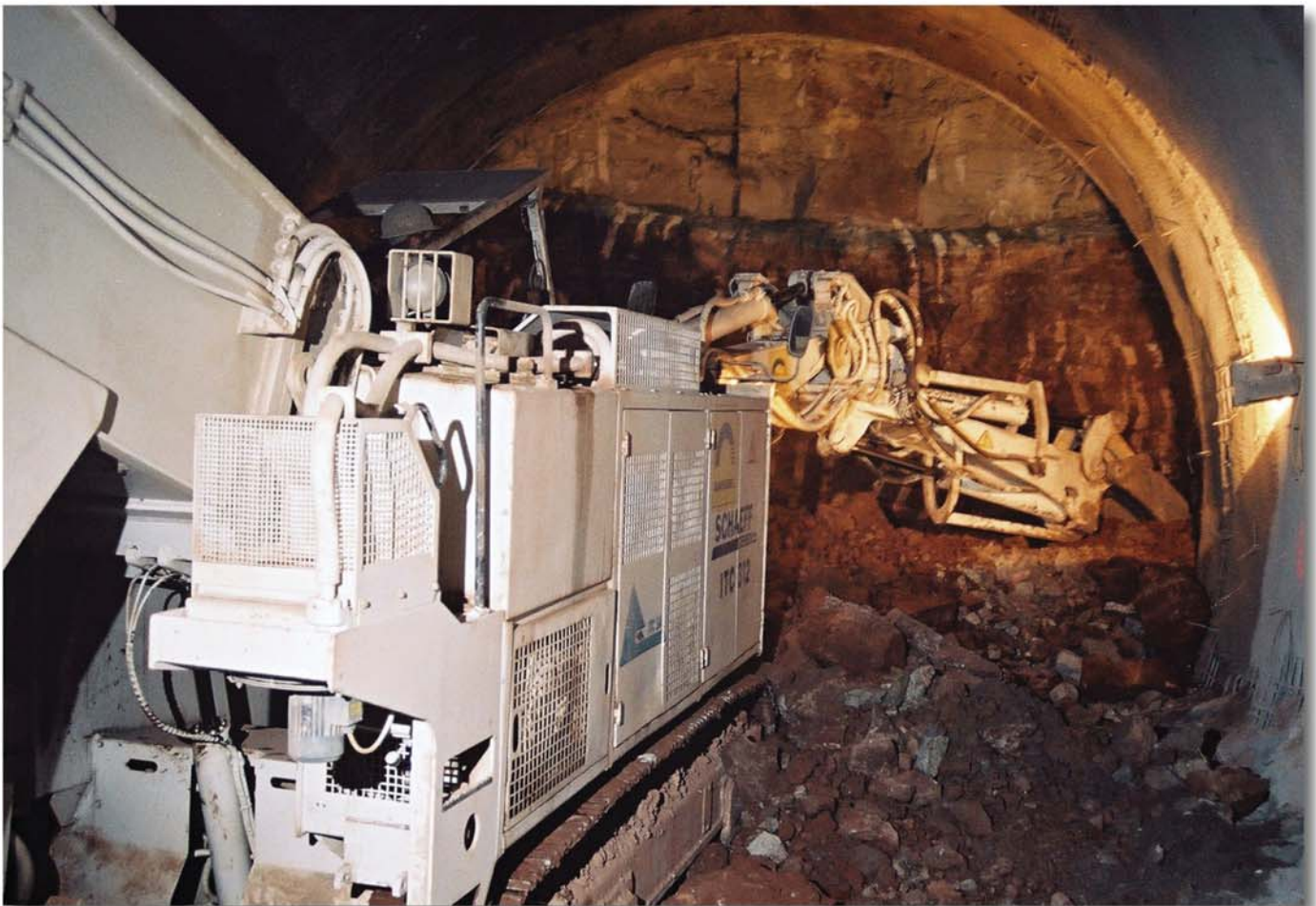
Bild 1: Tunnelvortriebs- und Lademaschine Schaeff Typ ITC 312 beim Lösen der Ulmenstösse
