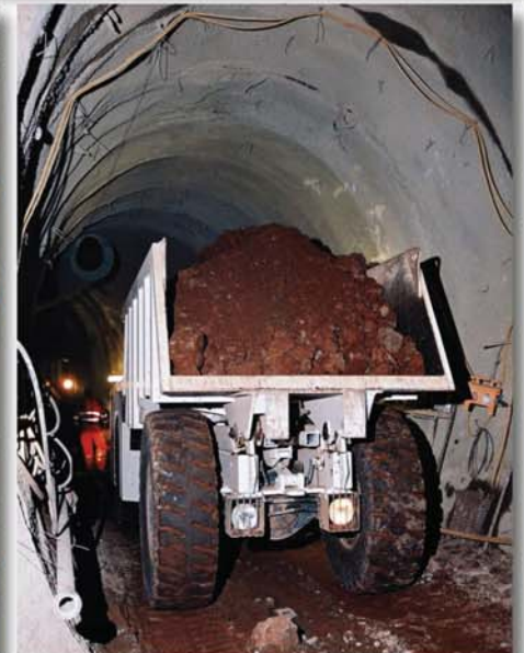
Bild 8: Enge Platzverhältnisse im Tunnel
