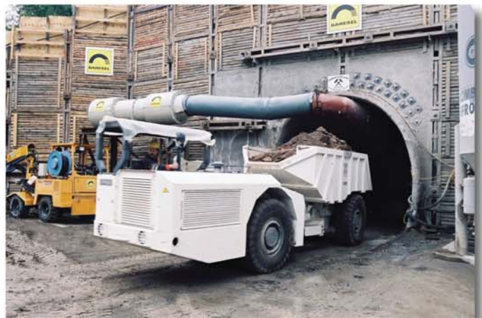
Bild 5: Beladener Dumper ITC 10000 am Tunnelportal
