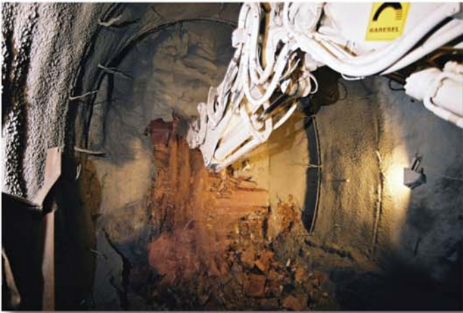
Bild 4: ITC 312 beim Abbau der Ortsbrust
