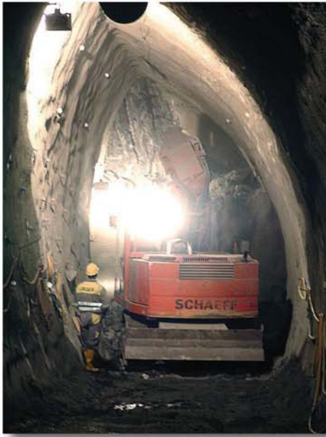
Linker Ulmenstollen: der Schaeff-Tunnelbagger TE 200 beim Reissen der voreilenden Kalotte
