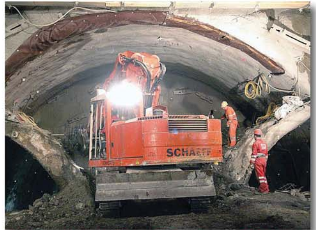
Kalottenvortrieb: der Schaeff-Tunnelbagger TE 200 beim Abbau
