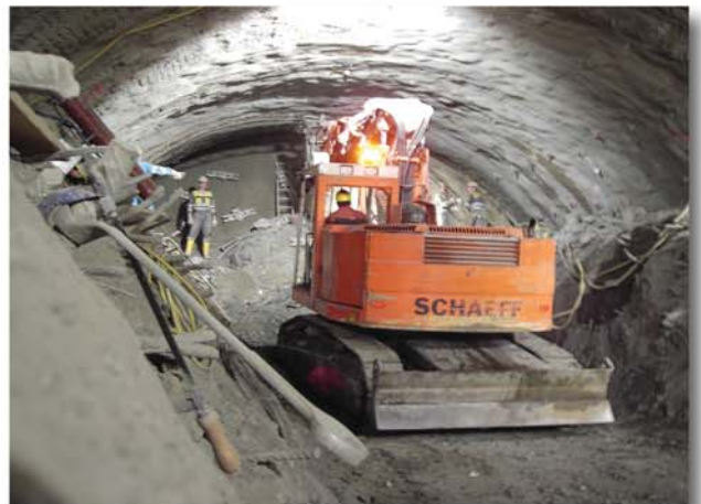
Kalottenvortrieb: der Schaeff-Tunnelbagger TE 200 beim Bogensetzen
