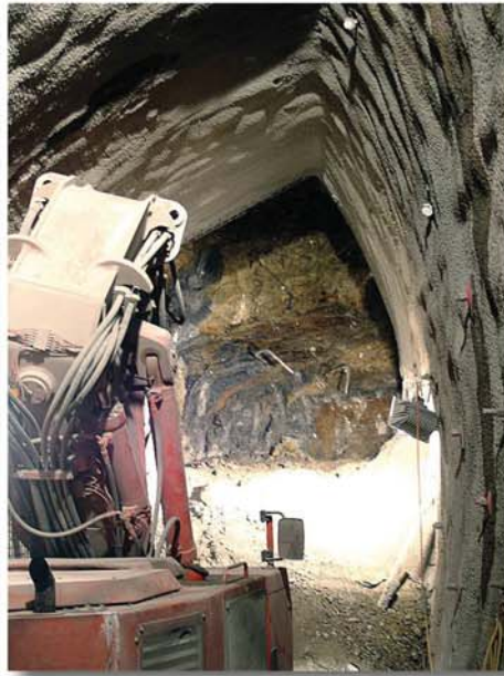
Rechter Ulmenstollen: der Schaeff-Tunnelbagger TE 200 beim Reissen der Strosse
