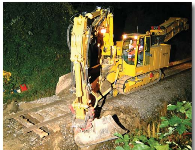
Genaueres Arbeiten dank Roto-Tilt Einrichtung
