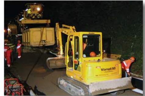
Frischer Materialtransport mit dem Kran
