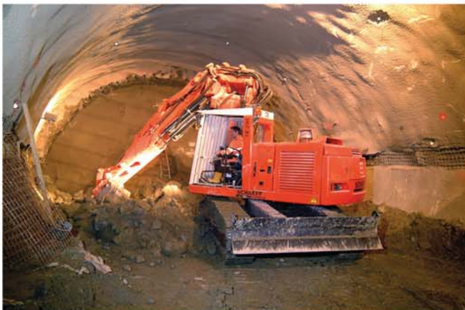
Der Tunnelbagger Typ TE 210 im Tunnelquerschnitt 37 m 2 , Firsthöhe 6 m
