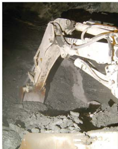
Der Superloader beim Sohlenreinigen
