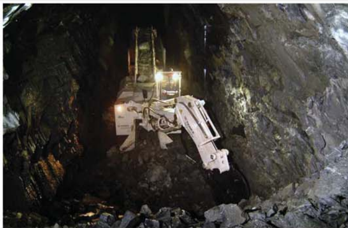
Die Schuttermaschine voll im Einsatz, 10 m 3 Haufwerk werden pro Minute auf LKW geladen
