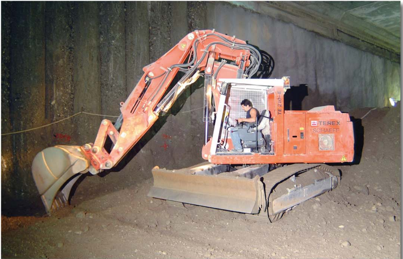
Der Elektrotunnelbagger Typ TE 210E im Druckluftvortrieb zwischen die Pfahlbohrwände
