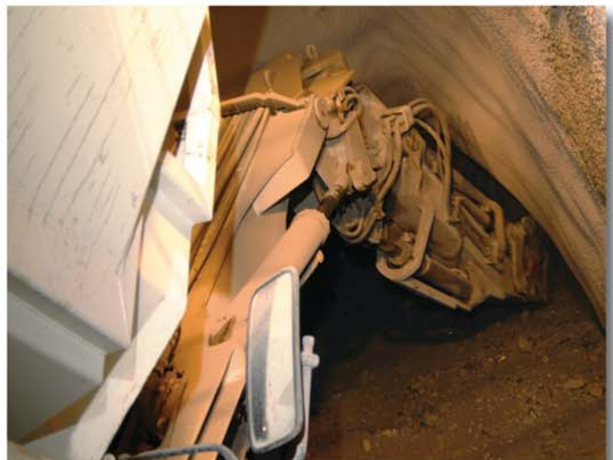
Genaueres Lösen hinter den Trägern
