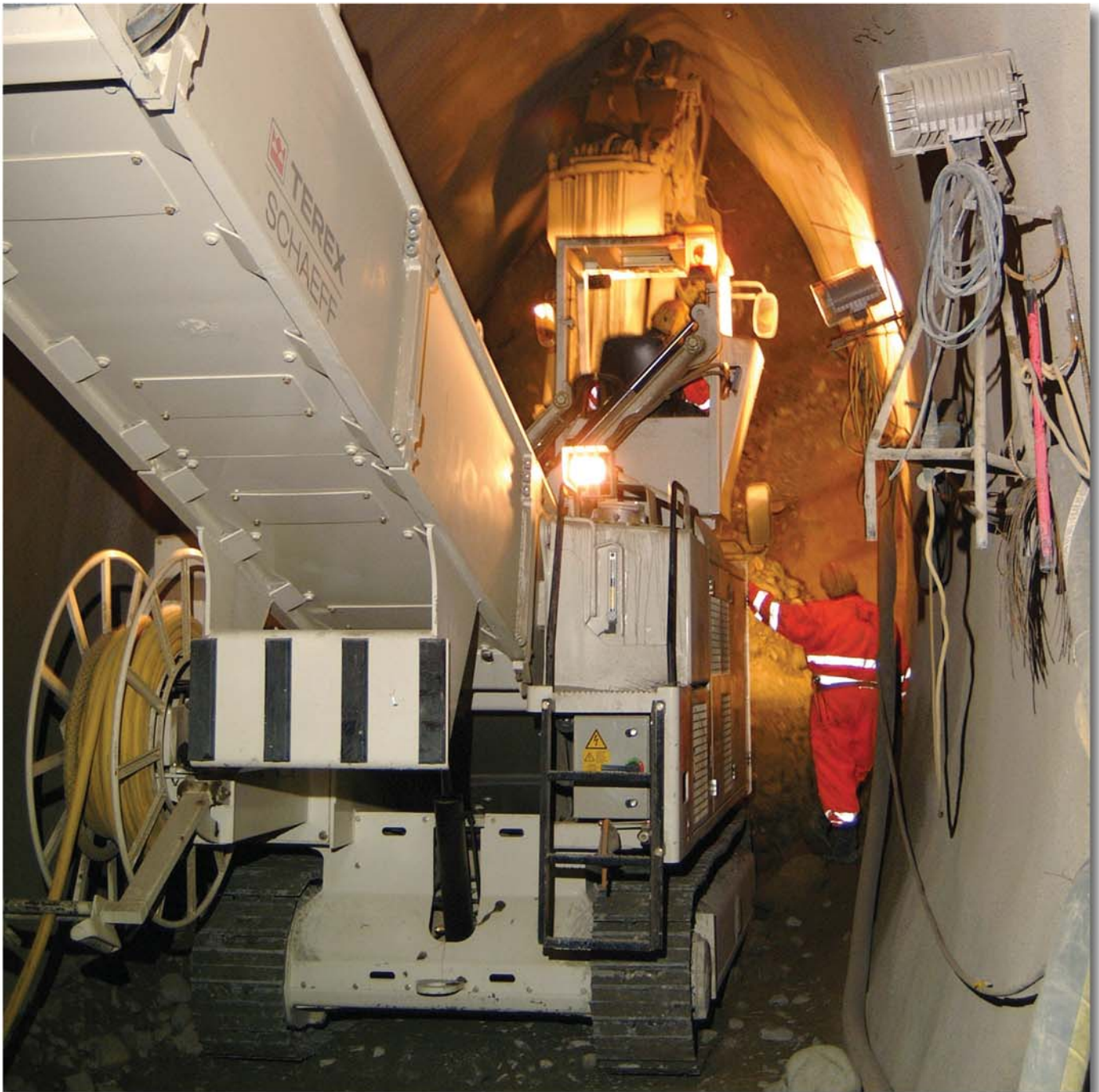
Die Tunnelvortriebsmaschine Schaeff Typ ITC 312 N1s in Aushubposition im rechten Ulmenstollen
