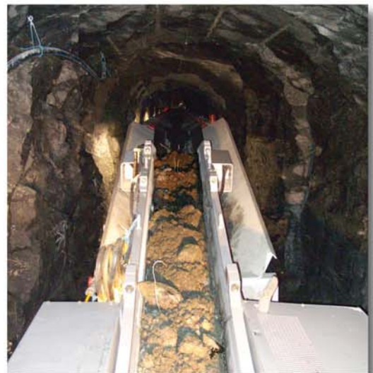
Kontinuierliches Laden des gesprengten Material
