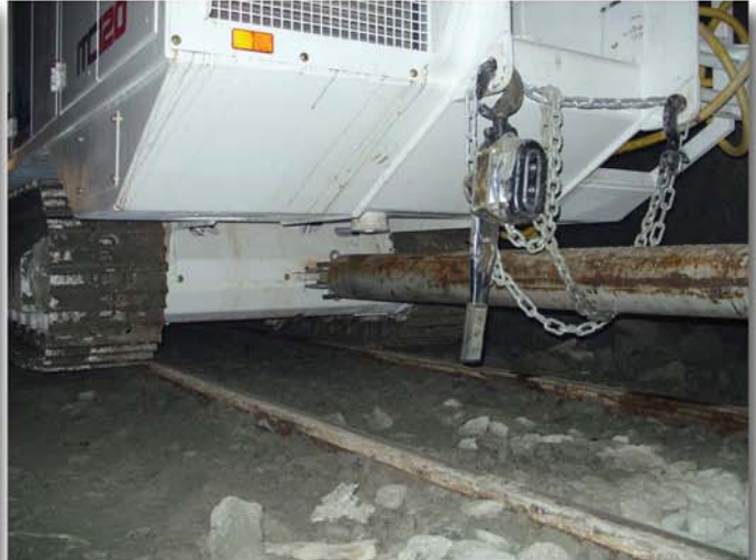
Starre Verbindung zwischen Lademaschine und Nachläufer, alles auf 900 mm Gleis
