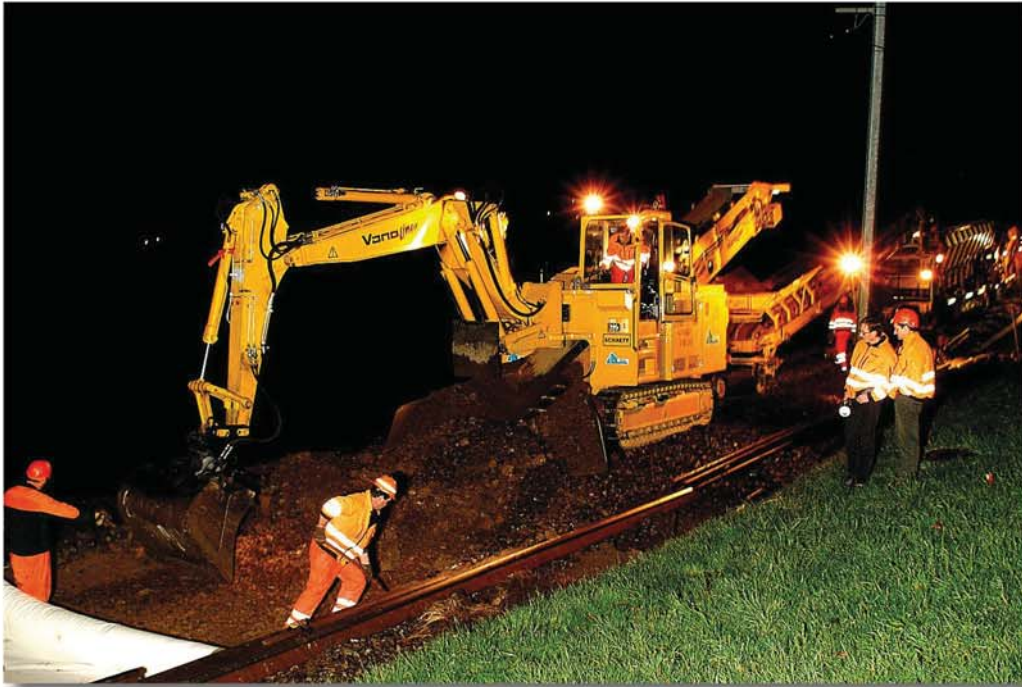
Fig. 7: Terrassement entre le talus et la route dans 50 % de pente.
