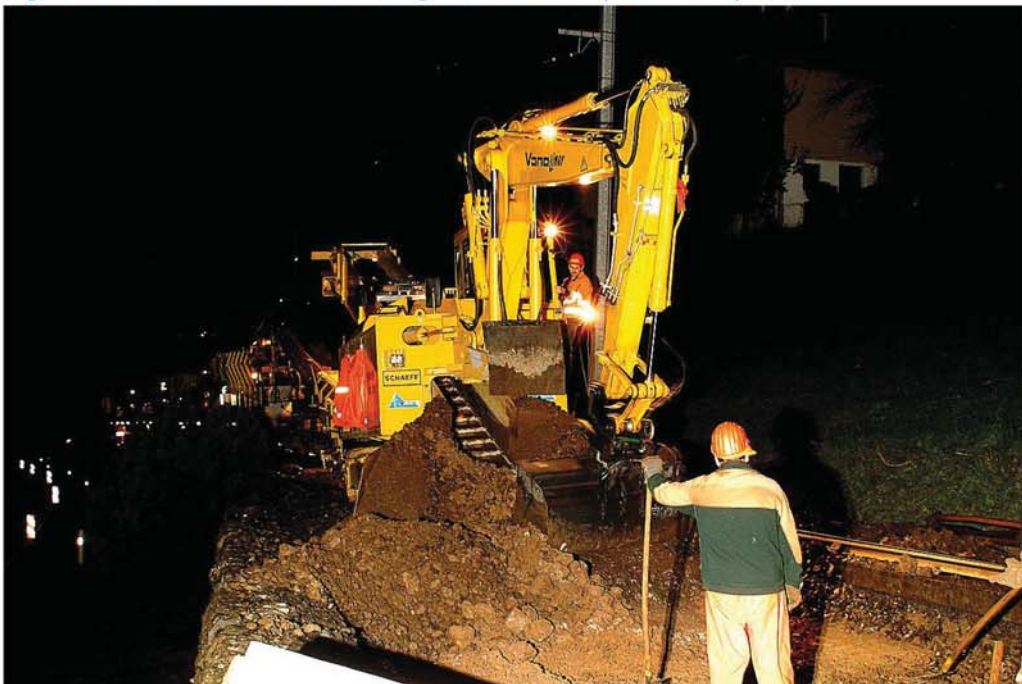
Fig. 8+9: Terrassement avec ménagement avec la plus haute précision
